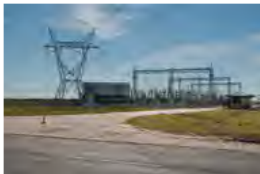
OBRAS DE INFRAESTRUCTURA LINEAL EN LA REGIÓN CHAQUEÑA
