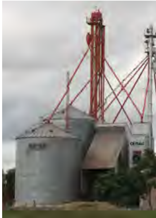
SILO PARA ALMACENAJE DE SOJA, PROVINCIA DEL CHACO.
