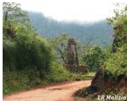
Monolito, en el Abra de Cañas, construido con motivo de la inauguración de la Ruta Provincial 3 (hoy 83) el 5 de octubre de 1950.
