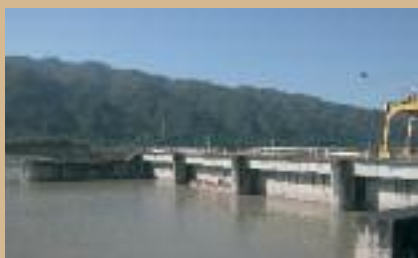
Dique derivador Los Molinos, sobre el Río Grande. / LR Malizia
