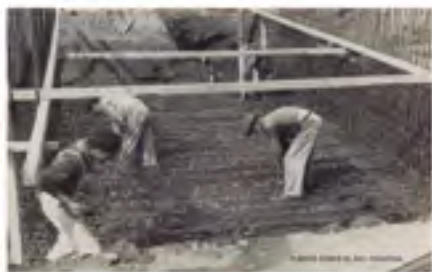
CONSTRUCCIÓN DEL TRAMO SANTA LUCÍA, LA RAMADITA.
