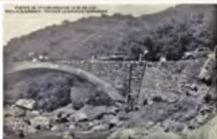
VISTA DE LA BÓVEDA TERMINADA, RÍO ANGSTURA.
