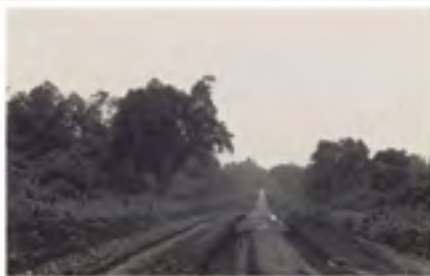
TRAMO SANTA LUCÍA, LA RAMADITA.
