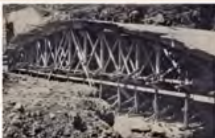
CONSTRUCCIÓN DEL PUENTE DE HORMIGÓN, RÍO ANGSTURA.
